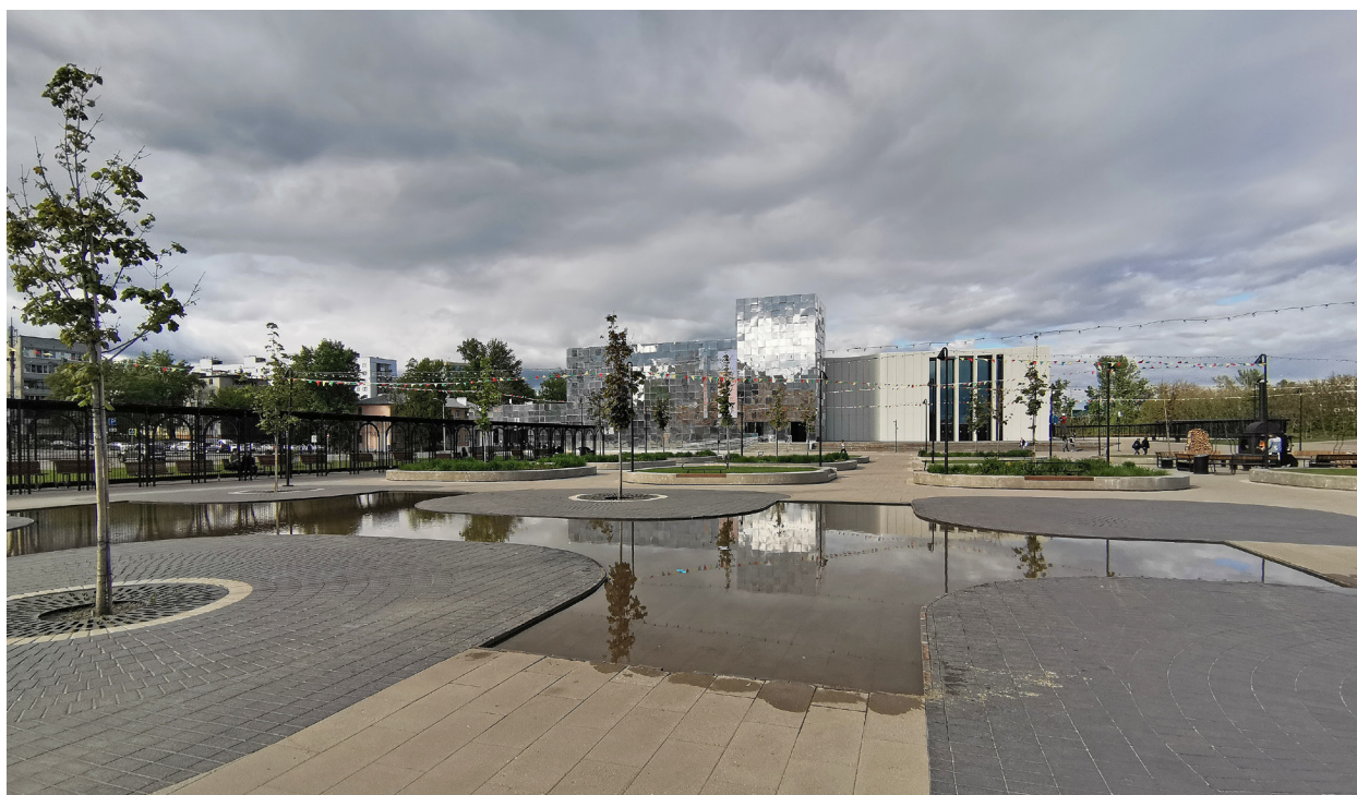
Площадь перед Нижегородской ярмаркой (бюро Megabudka): зеркальный выставочный павильон № 1 (первоначально бюро «Архстрой») и выставочный павильон № 2 (архитектор С. В. Горшунов). Фотография М. В. Дуцева, 2023 г.
