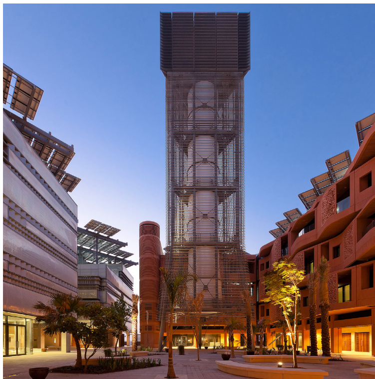
Воздухозаборная башня для охлаждения пешеходных улиц в г. Масдаре. Архитектор Н. Фостер
