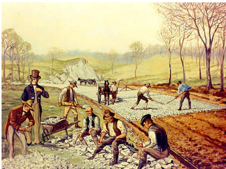
Рис. 10. Строительство трассы Кумберленд-роуд в штате Мэриленд по методу Джона Макадама 1830 год. http://www.1-day.ru/sob_09_21_1756.html
