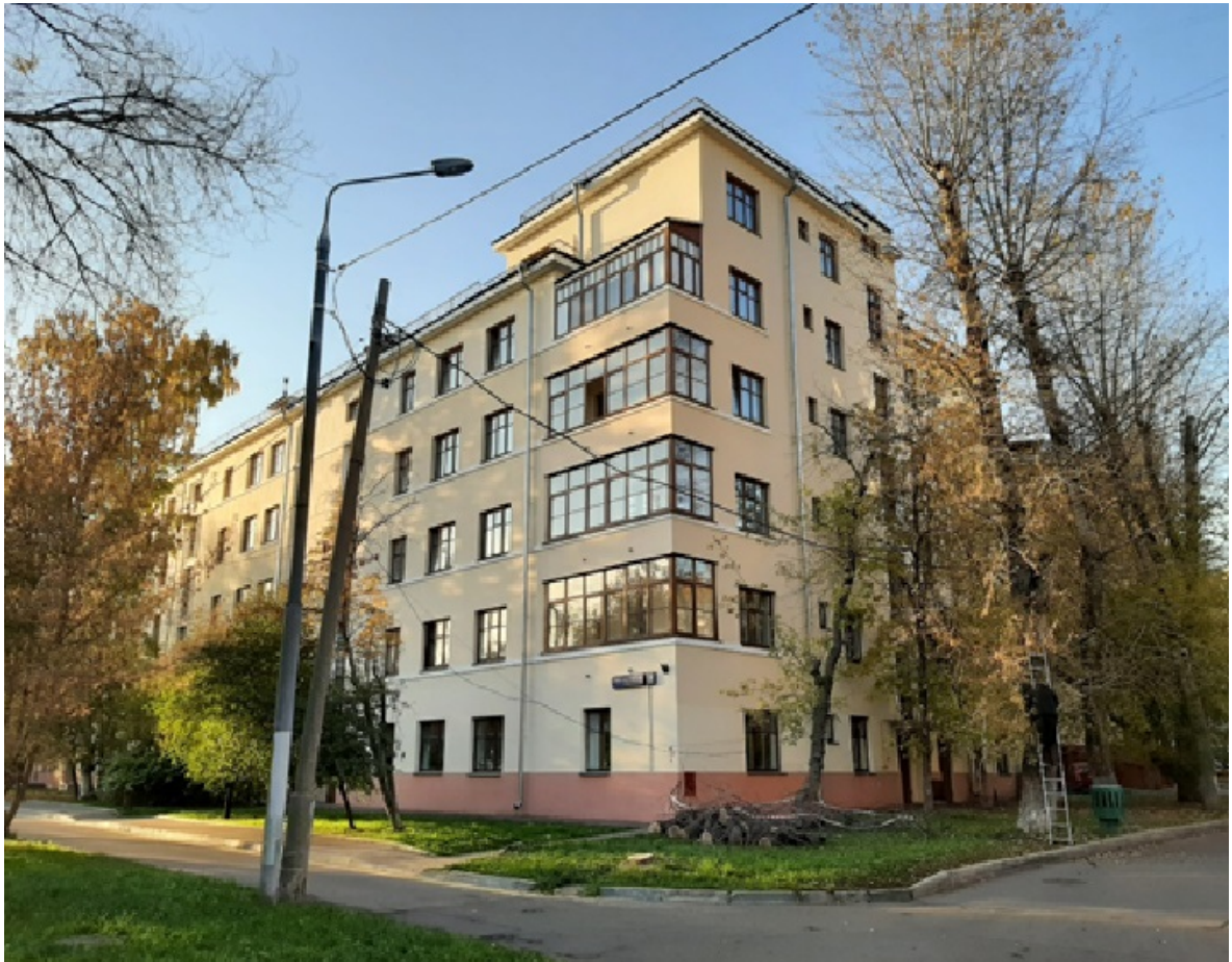
Рис. 7. Жилой комплекс на Преображенском валу. Арх. И.С. Николаев, М.М. Русанова, Г.М. Мапу. 1927-1929 гг. Жилой дом после проведения капитального ремонта. Фотография автора (2021 год).
