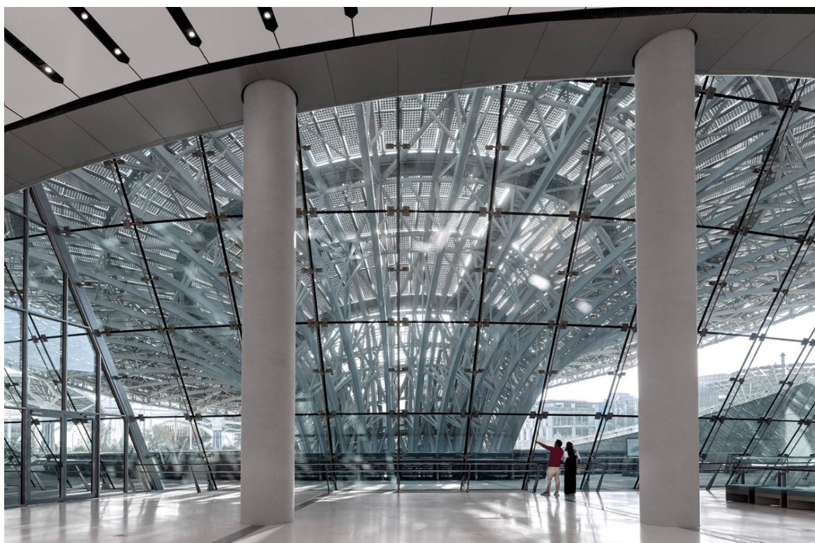
Рис. 17. Вид на структуру павильона “Terra”. Комплекс «Устойчивое развитие». Дубай (ОАЭ). Арх. бюро “Grimshaw Architects”.
