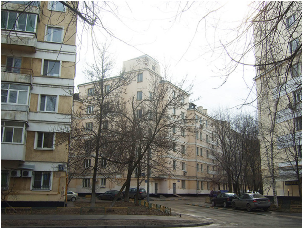
Рис. 5. Хавско-Шаболовский жилмассив. Бригада АСНОВА. 1927-1928 гг. Общий вид жилой застройки. Фотография автора (2016 год).
