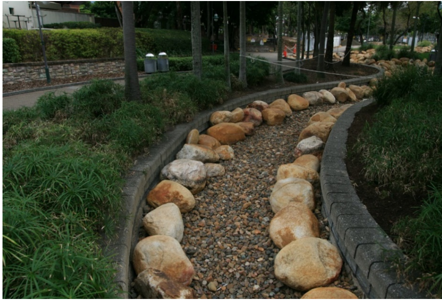
Рис. 16. «Сухой ручей» - фрагмент дренажной системы набережной Брисбэна. Фото И.В. Кукиной.
