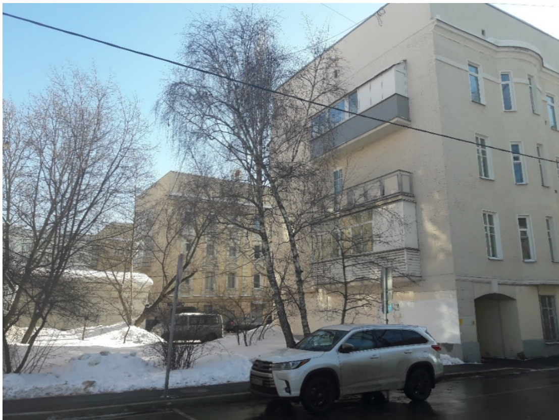
Рис. 1. Комплекс жилых домов в Товарищеском переулке. Фотография автора (2018 год).
