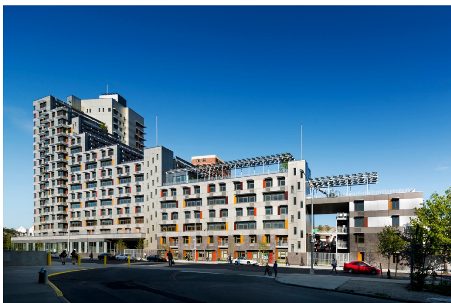
Рис. 9. Основное здание комплекса «Зелёная улица» в Южном Бронксе. Нью-Йорк (США). Арх. бюро “Grimshaw Architects”. 2012.
