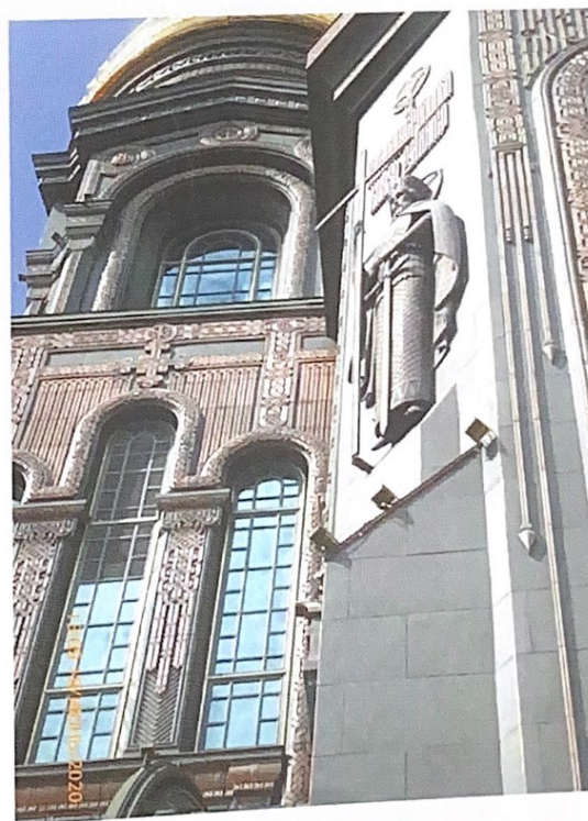
Фрагмент фасада Храма с элементами декора из стеклофибробетона и скульптурными барельефами
