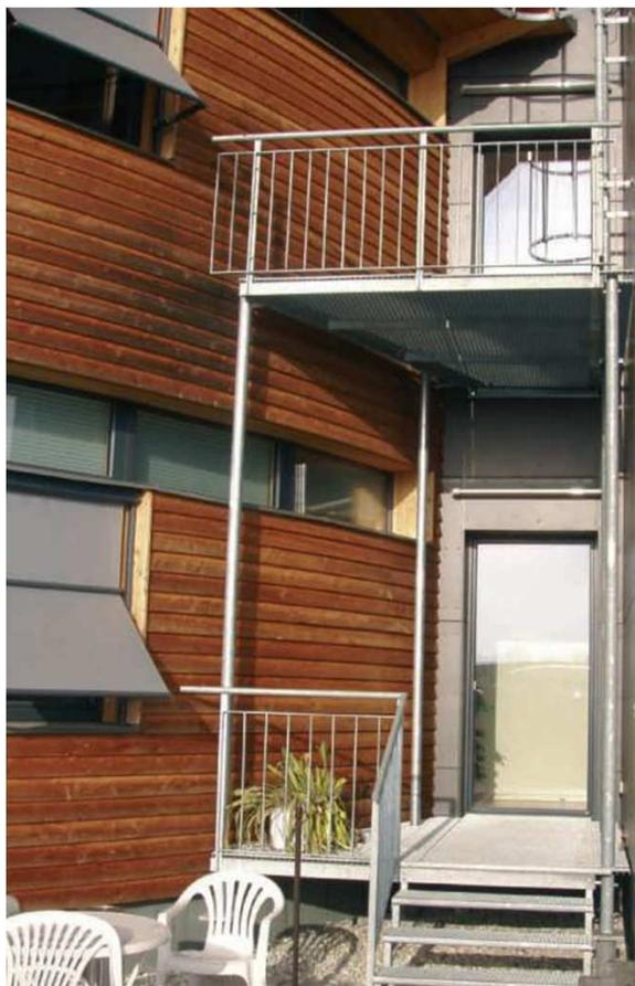
Установленные на кронштейнах или отделенные балконы – самое простое решение.
